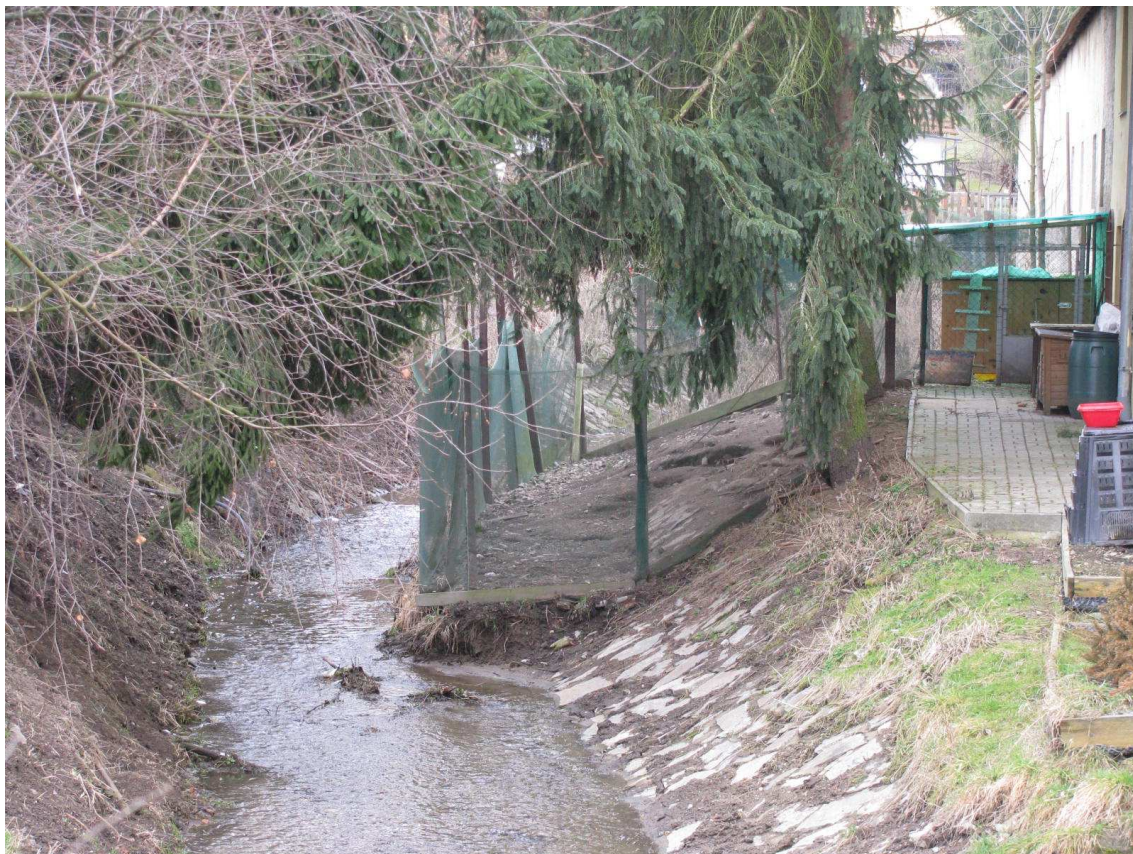
obr. 9– oplocení sousedícího pozemku 280/2 zasahující do koryta toku
